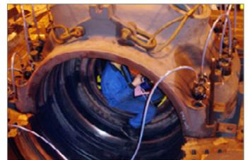
原子力発電の蒸気タービンケーシング
